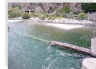
Vista dell'area dove realizzare il primo bacino
