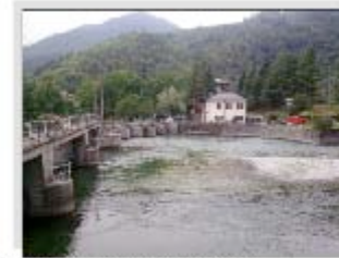
Sbarramento -vista a monte-
